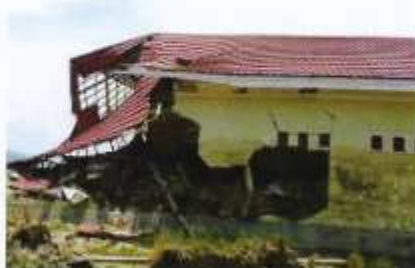
Perpindahan Lateral Tanah ( Lateral Spread ) di Sigi
