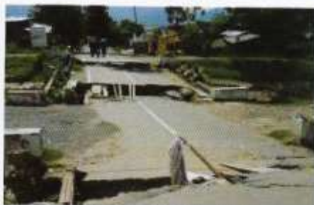
Perpindahan Lateral Tanah ( Lateral Spread ) di Sigi
