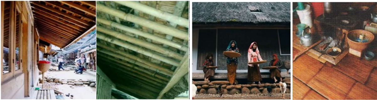
Gambar 10. Atap rumah dan lantai Sumber: Handayani, S (2009)
