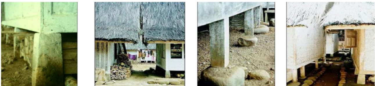
Gambar 08. Pondasi umpak pada rumah Sumber: Handayani, S (2009)
