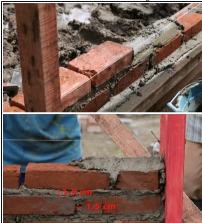
Gambar 41. Proses Pemasangan Batu Bata Untuk Dinding
