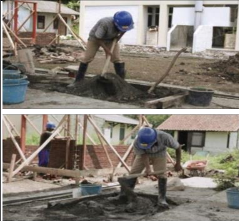
Gambar 8. Proses Pencampuran Mortar
