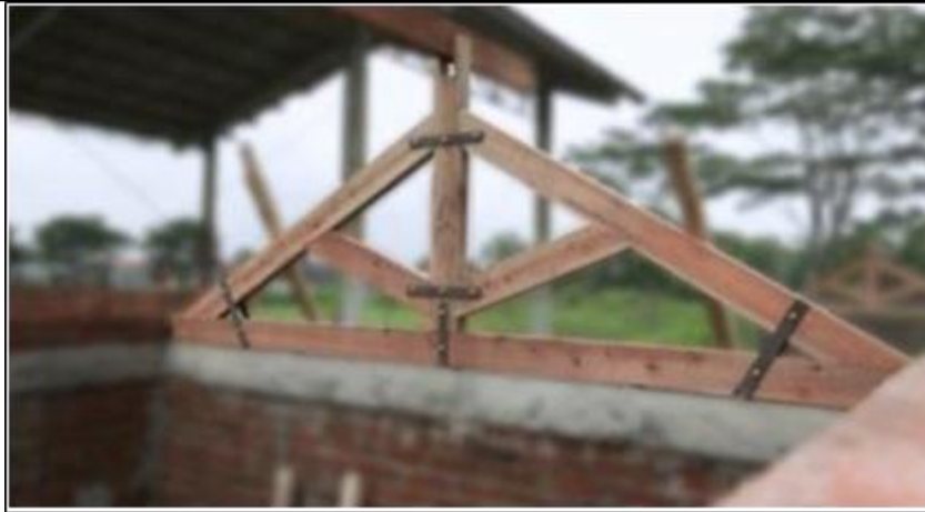
Gambar 28. Kuda-kuda Kayu Dengan Pengikat Plat Baja
