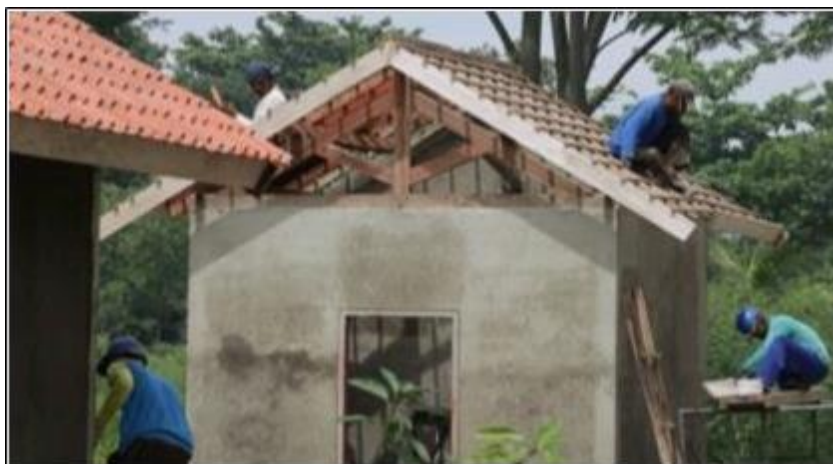
Gambar 27. Kuda-kuda Kayu Pada Atap Rumah Tinggal Ikatan antar batang pada kuda-kuda kayu diperkuat dengan plat baja dengan ketebalan 4 mm dan lebar 40 mm atau papan dengan ketebalan 20 mm dan lebar 100 mm.
