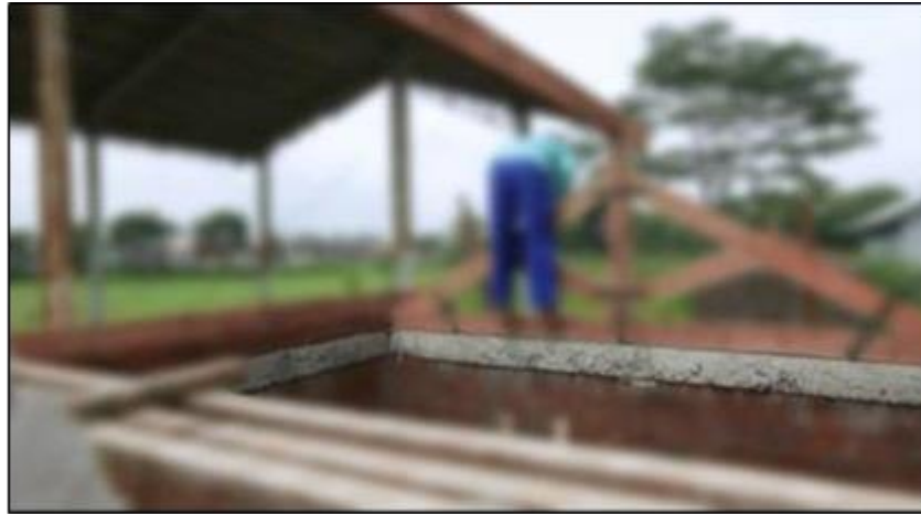
Gambar 22. Balok Keliling/ Ring
