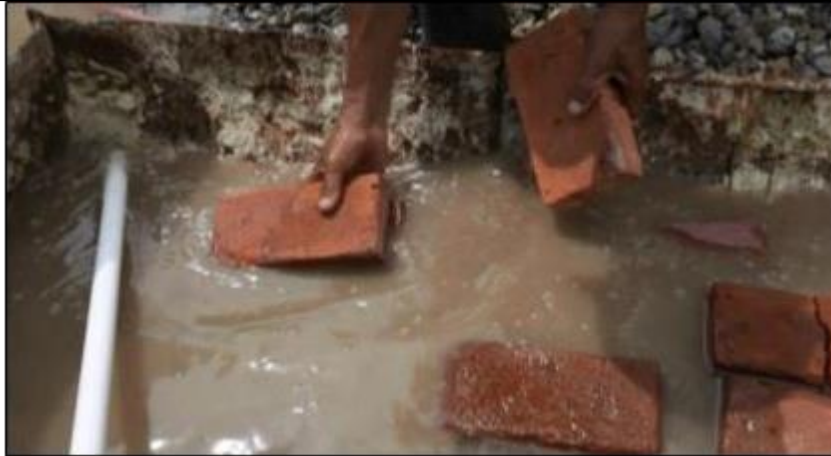
Gambar 15. Perendaman Batu Bata Sebelum Dipasang
