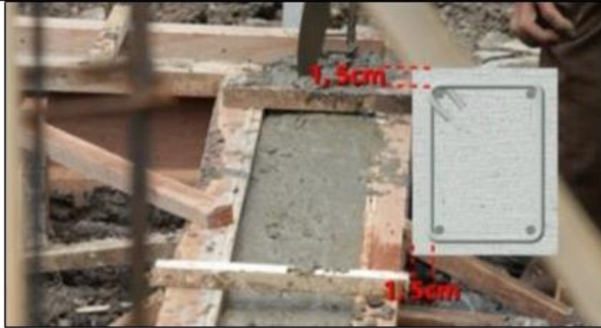
Gambar 19. Balok Pengikat/ Sloof
