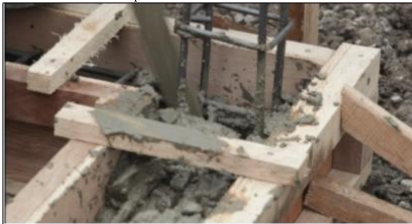
Gambar 58. Pengecoran Balok Pengikat/ Sloof
