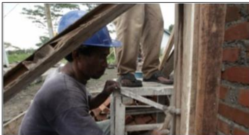
Gambar 56. Proses Pengecoran Kolom
