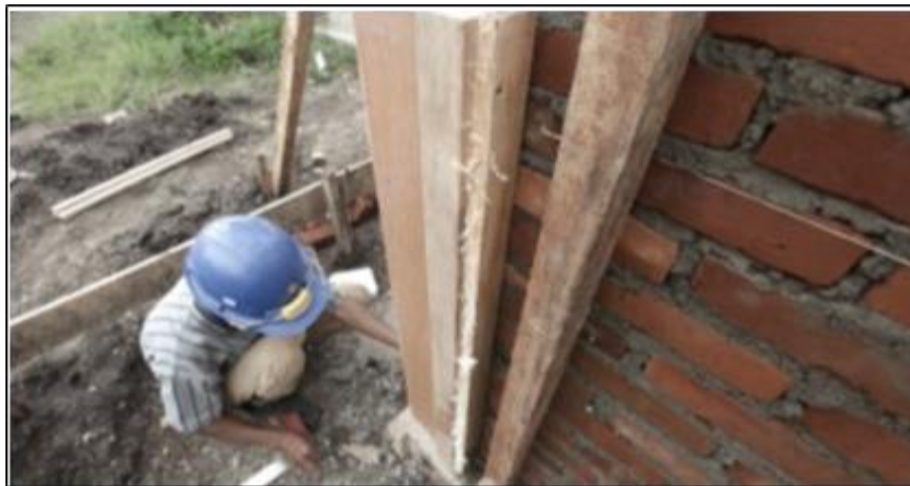
Gambar 55. Pemasangan Cetakan/ Bekisting Untuk Kolom
