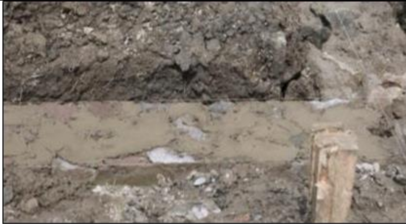
Gambar 11. Pondasi Dari Batu Kali/Gunung
