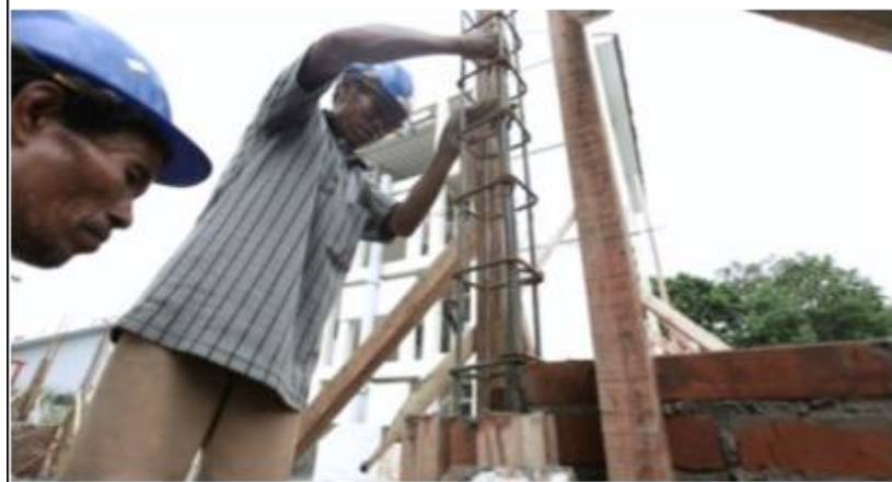
Gambar 57. Pemasangan dan Pemasangan Beton Dengan Memukul-mukul Cetakan/ Bekisting dan Campuran Beton Dirokok Menggunakan Besi atau Bambu
