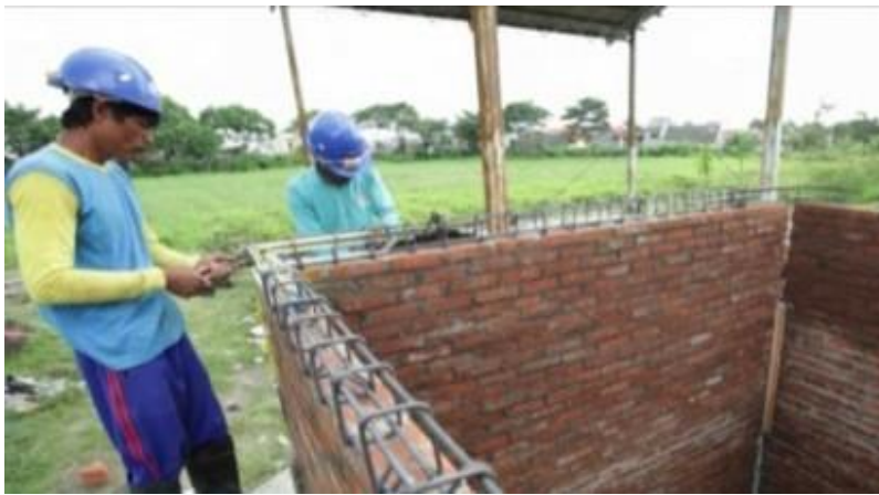
Tulangan balok keliling/ ring dirangkai di atas dinding
