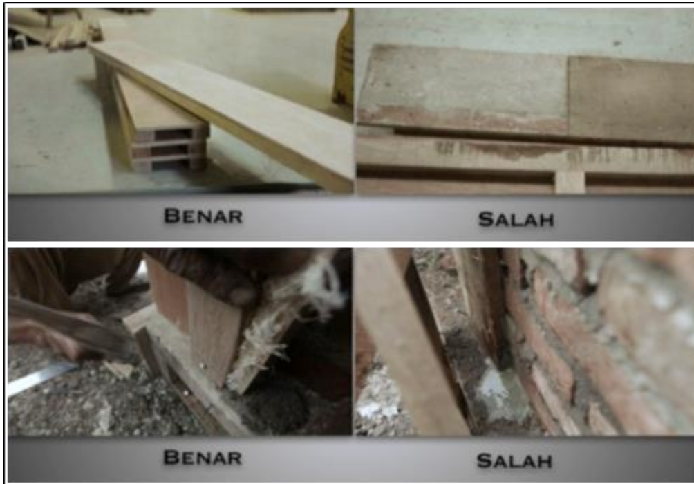
Gambar 54. Kualitas Cetakan/ Bekisting
