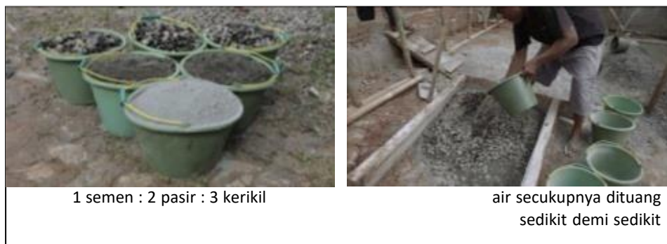
Gambar 2. Pencampuran Beton
