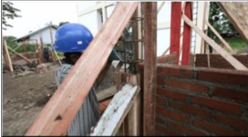
Gambar 56. Proses Pengecoran Kolom
