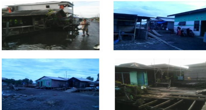
Gambar 7. Kondisi Struktur dan Material (Sumber : Survei Lapangan, 2015)
