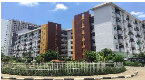
Gambar 10. Bentuk Fisik Bangunan Rumah Susun Daan Mogot, Jakarta Barat (Sumber : Peneliti, 2020)
