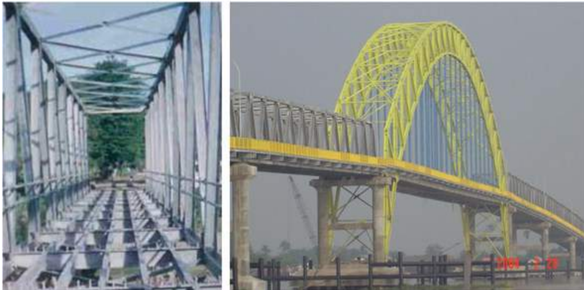
Gambar 1. 6 Jembatan Baja di Sumatera.
