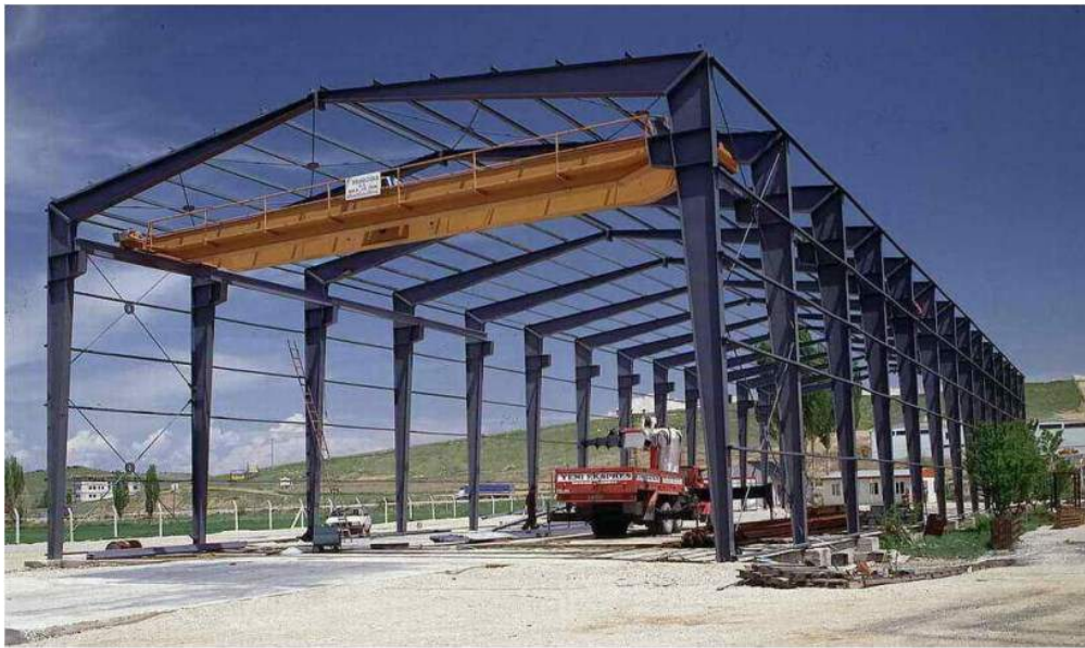
Gambar 1. 10 Pembangunan Gudang dengan menggunakan material Baja.
