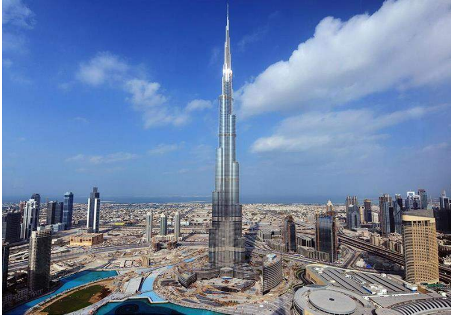
Gambar 1. 9 Burj khalifa dubai adalah sebuah gedung pencakar langit di Dubai, Uni Emirat Arab.
