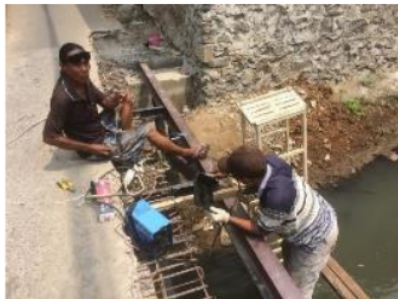
Gambar 12. Pengarahan untuk Pekerjaan Pembesian
