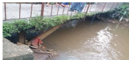
Gambar 2. Bagian bawah jembatan penyebrangan Cawang eksisting
