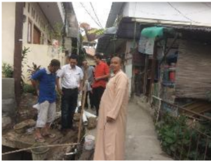
Gambar 11. Pendampingan oleh Tim PKM pada proses konstruksi
