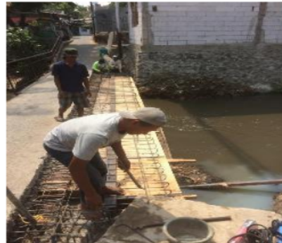
Gambar 13. Pekerjaan pembesian pada Jembatan Cawang
