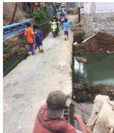
Gambar 10. Persiapan Konstruksi Pelebaran Jembatan Cawang
