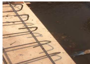
Gambar 14. Detail pembesian pada Jembatan Cawang
