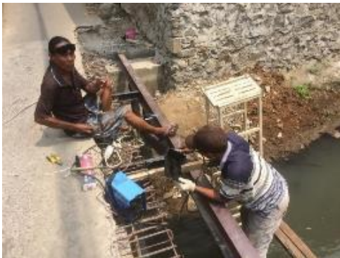
Gambar 12. Pengarahan untuk Pekerjaan Pembesian
