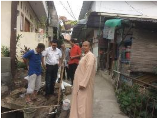
Gambar 11. Pendampingan oleh Tim PKM pada proses konstruksi
