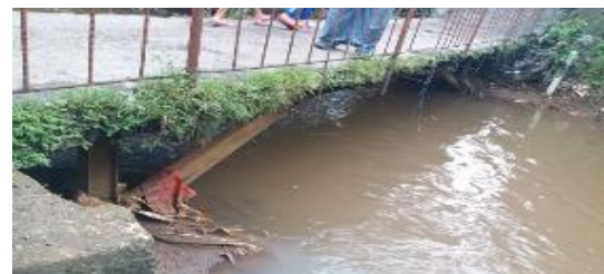
Gambar 2. Bagian bawah jembatan penyebrangan Cawang eksisting
