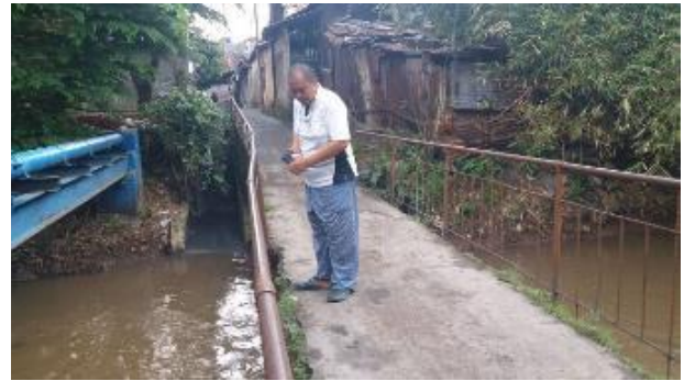
Gambar 6. Lurah Cawang Melakukan Inspeksi Kondisi Eksisting Jembatan Penyebrangan Cawang
