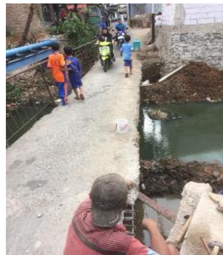
Gambar 10. Persiapan Konstruksi Pelebaran Jembatan Cawang
