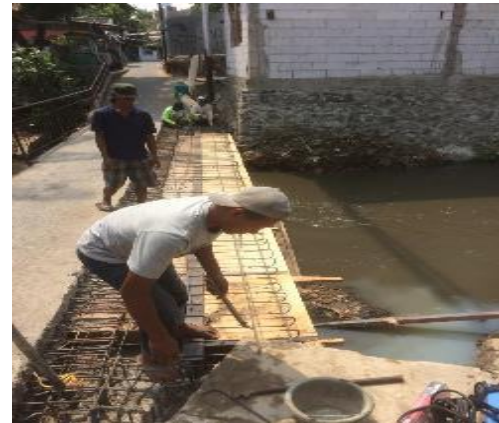
Gambar 13. Pekerjaan pembesian pada Jembatan Cawang
