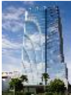
Gambar 11. Pemilihan material fasad transparent , pada jenis kaca, yang mampu mereduksi panas kedalam ruang, seperti: stopsol , tempered , double glass façade , dan sebagainya.
