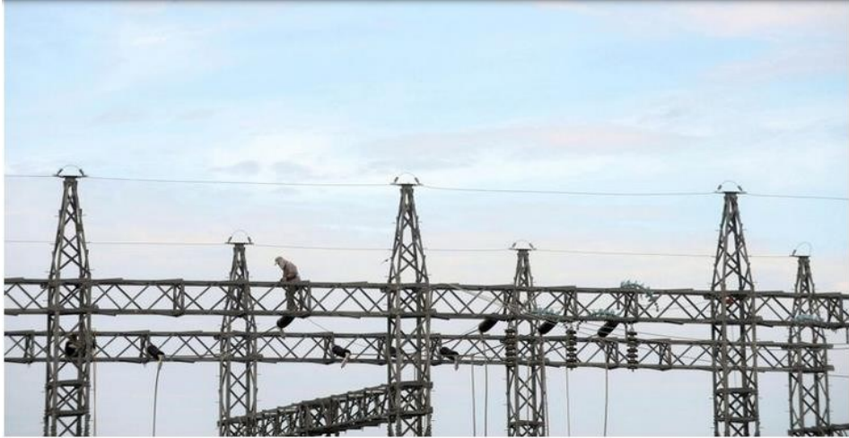
Pembangunan Pembangkit Listrik - Pekerja menyelesaikan pembangunan pembangkit dan jaringan listrik di Kecamatan Taliwang, Kabupaten Sumbawa Barat, Nusa Tenggara Barat, Selasa (12/4/2016). Pembangunan Pembangkit Listrik Tenaga Uap (PLTU) berkapasitas 2x7 megawatt tersebut untuk memenuhi kebutuhan listrik di kawasan Sumbawa. (KOMPAS/P RADITYA MAHENDRA YASA)
