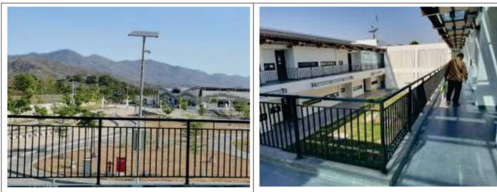
Gambar 9.11: Rumah/Apartemen Dinas PLBN Motaain (Sumber: koleksi sendiri)
