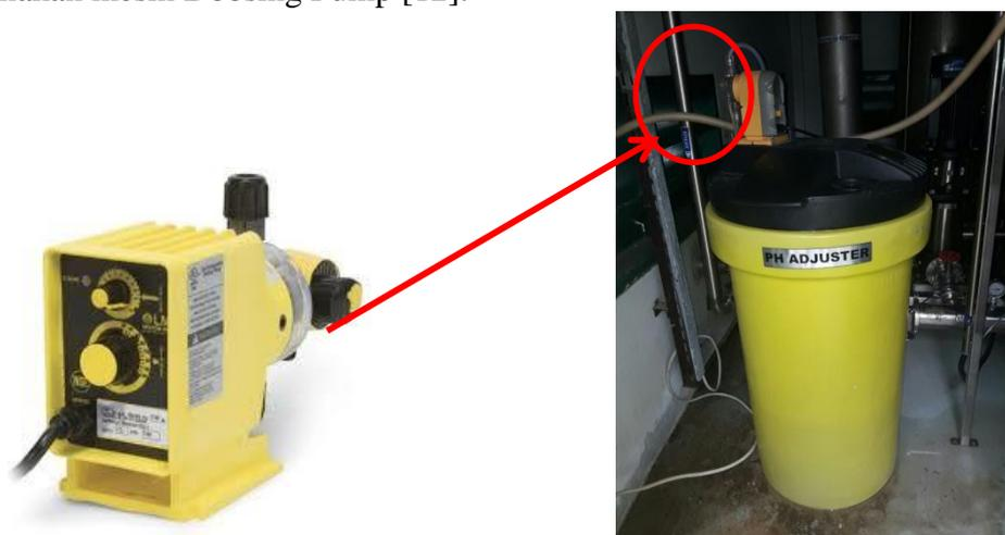
Gambar 4.1 Mesin doosing pump dan pemasangannya di raw water
