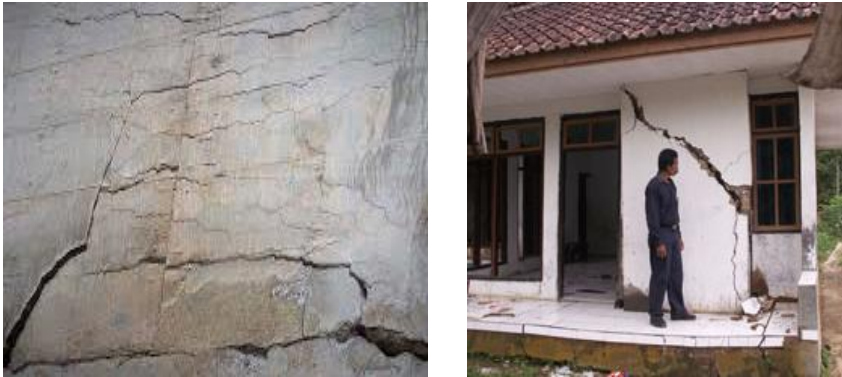
Gambar 2.1. Kerusakan mekanis pada beton bertulang (sumber: solusikonstruksi.com dan imagebali.net)
