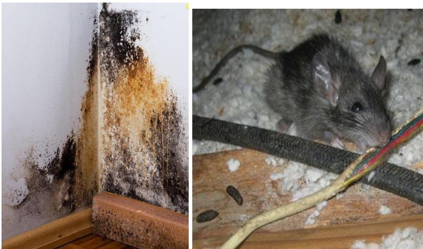
Gambar 2.7. Kerusakan biologis pada dinding karena jamur (sumber Ajeng Quamila) dan kabel listrik (attic-rat.com).
