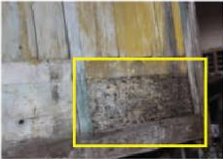
Gambar 2.5. Pelapukan yang terjadi pada bangunan cagar budaya Istana Raja Dompu (Sumbawa) akibat proses/reaksi kimia (sumber: Artanegara)
