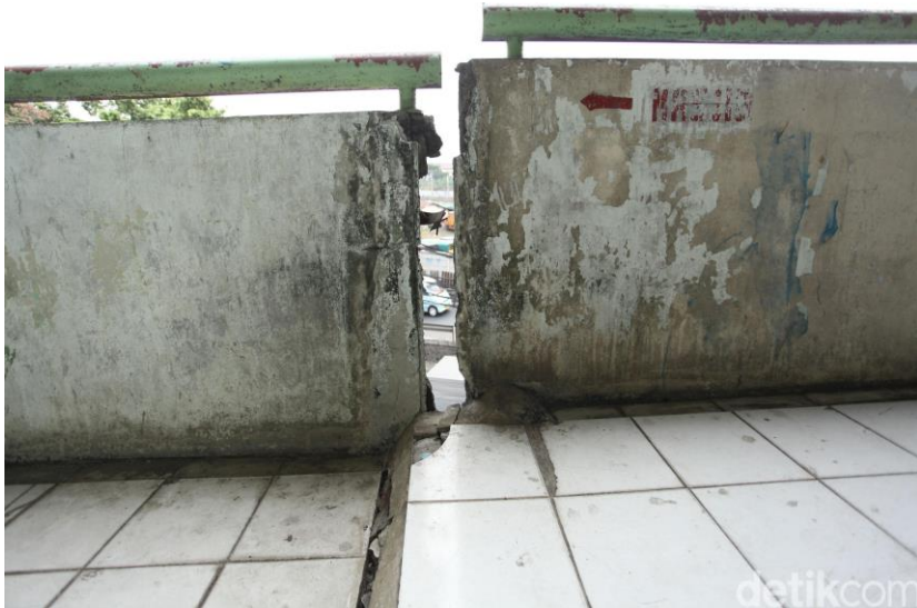
Gambar 2.3. Kerusakan fisik akibat penambahan bangunan (sumber: Rifkianto Nugroho).
