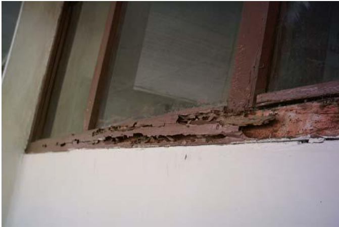
Gambar 2.6. Kerusakan biologis akibat serangan rayap (sumber: Ruli Herdiansyah).
