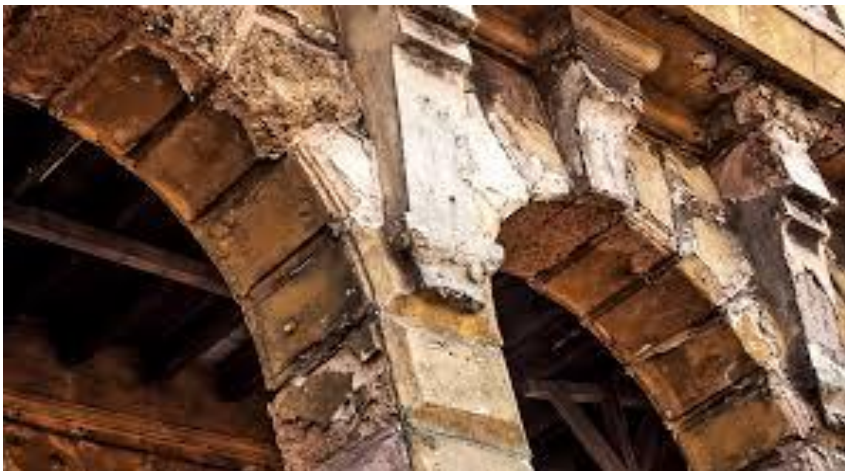
Gambar 2.4. Kerusakan kimia (garam) pada gedung cagar budaya yang terletak dekat dengan pantai di kota Havana (sumber: Julio Llopiz/ETH Zurich)
