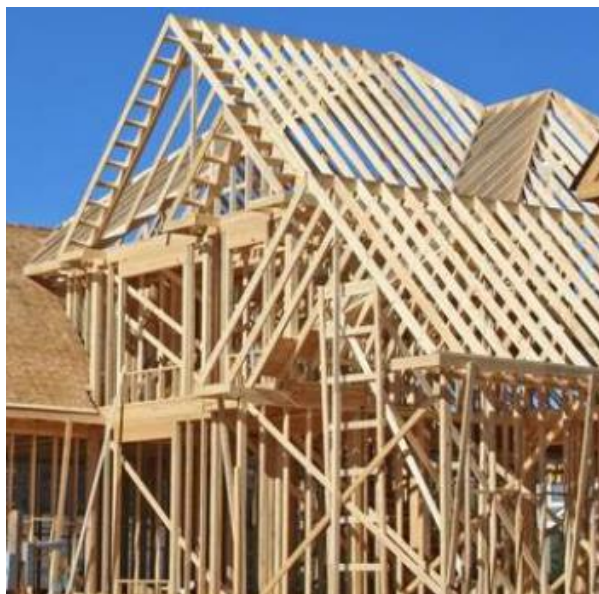
Gambar 5.1. Struktur rangka kayu (sumber: google image)
