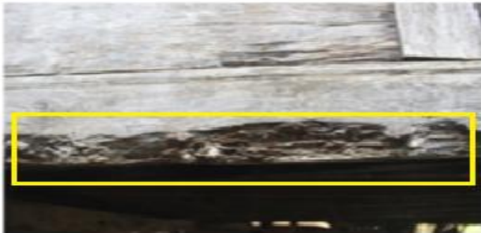
Gambar 2.2. Kerusakan pelapukan fisik (sumber: Artanegara)
