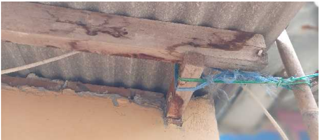
Gambar 7. Faktor rembesan air pada bahan kayu perlu dicari pemecahan masalahnya (2)
