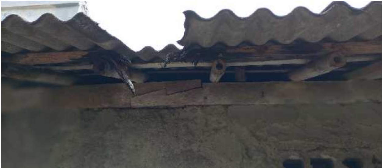
Gambar 6. Faktor rembesan air pada bahan kayu perlu dicari pemecahan masalahnya (1)
