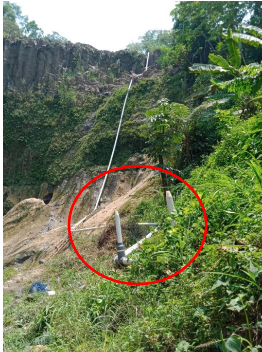
Gambar 3. Lokasi pembuatan rumah turbin
