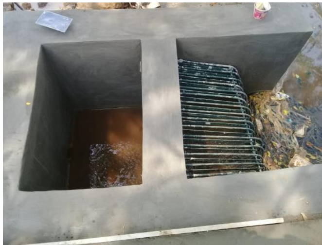
Gambar 2. Kolam penenang proyek mikrohidro yang telah selesai dibangun.
