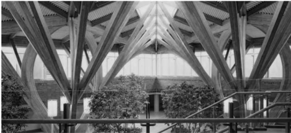
Gambar 2. Bentuk fleksibel dari struktur dengan kayu rekayasa.
