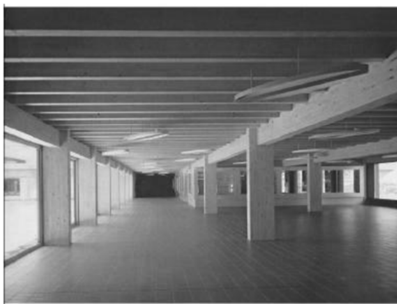
Gambar 3. Sistem struktur balok dan kolom dengan kayu glulam (Kolb, 2008).
