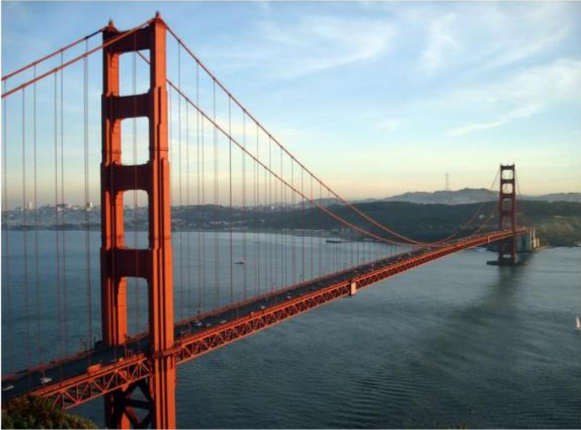
**Gambar 2.8** Golde Gate Dridge memiliki frekuensi alamiah 0,055 Hz untuk getaran arah transversal, 0,092 Hz untuk getaran vertikal, 0,26 Hz untuk getaran agah longitudinal, dan 0,23 Hz untuk getaran torsional.
