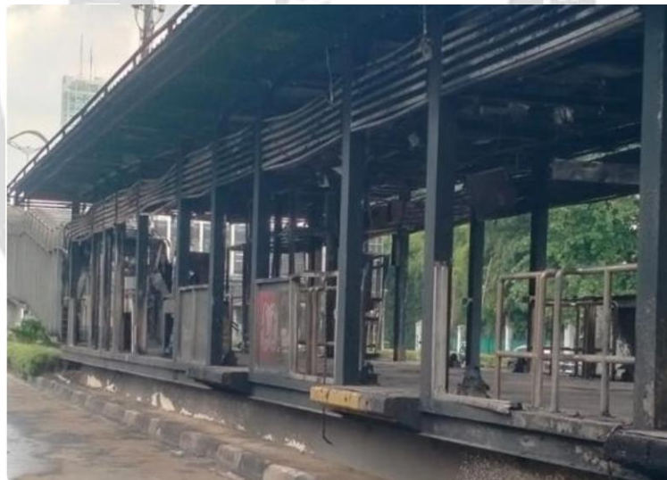
Gambar 1.3 Halte Polda Metro Jaya
