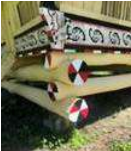
Gambar 10a. Balok tumpuk Sumber: Dokumen pribadi, 2019
