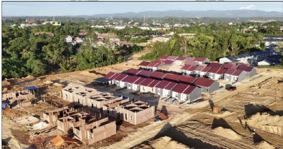
Gambar 1.5. Salah Satu Cut And Fill pada Pengembang Perumahan Sumber : Data Primer (2025)
