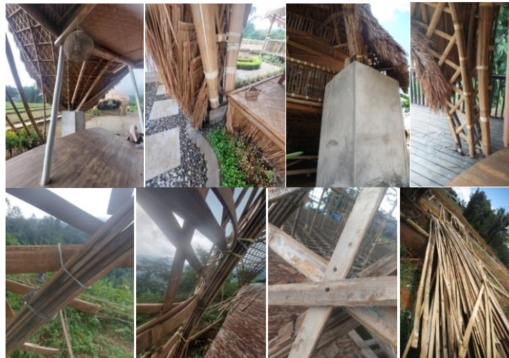
Sumber: Observasi Pattiroang café & resto Gambar 5. Sistem struktur bambu
