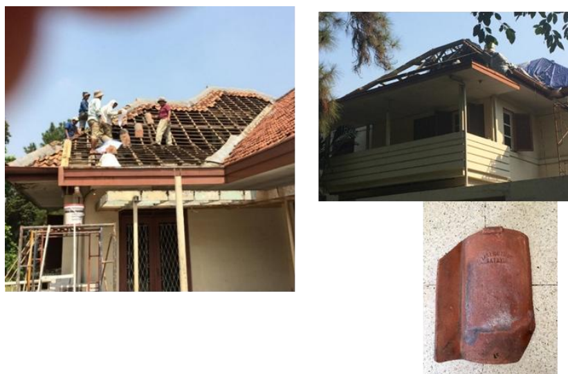
Gambar 12. Penggantian Rangka Penutup Atap
