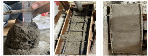
Gambar 5. Proses Pengecoran dan Uji Slump Beton
