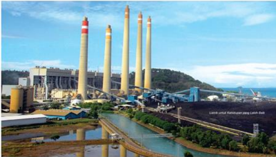
Gambar 1. 7. Pembangkit Listrik Tenaga Uap (PLTU).
