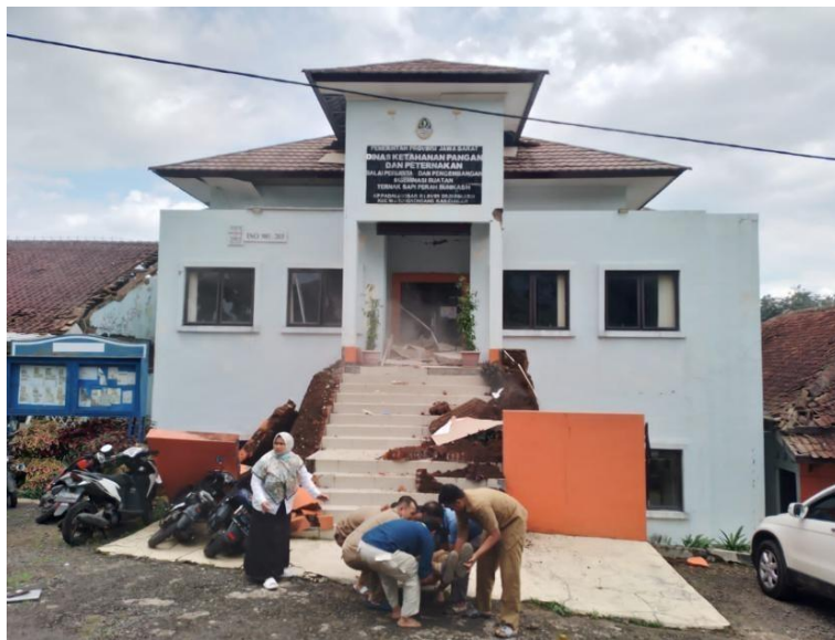
Gambar 1.3. Fasilitas Umum yang rusak akibat gempa
