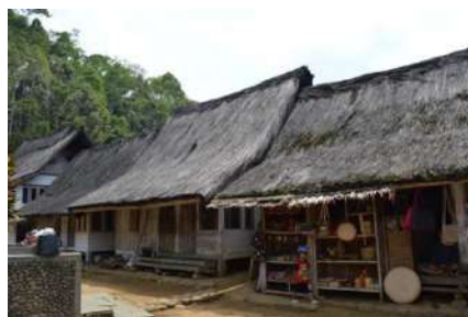
Gambar 4.19. Material Atap Ijuk Kampung Naga
