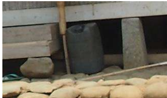
Gambar 4.18. Pondasi Umpak
