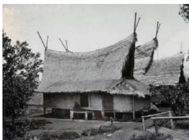
Gambar 2.3 Tampak Samping Rumah Dengan Atap Julang Ngapak (Sumber : dearchitectblog.wordpress.com)
