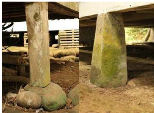
Gambar 4.25. Umpak batu utuh dan umpak batu pahat (Sumber: Wibowo, 2012)
