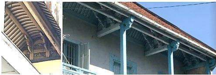
Gambar 4.49. Konsol Atap pendukung purlin di Kawasan Pecinan Semarang (Sumber: Dokumentasi Pribadi, 2022)
