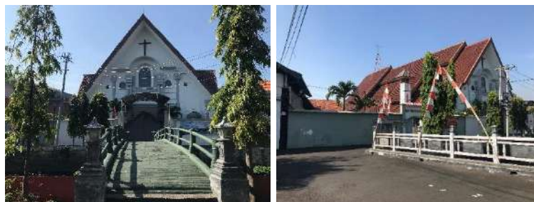
Gambar 4.16. Gereja Kebon Dalem (Sumber: Dokumentasi Pribadi, 2022)
