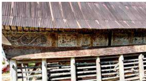
Gambar 47 Dinding Rumah Sigumpar (Sumber: Dokumentasi Pribadi, 2021)
