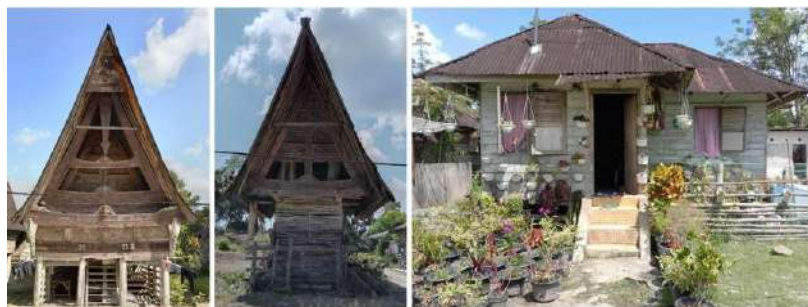
Gambar 44 Tipologi Bangunan Sigumpar (Jabu; Sopo; Rumah Eper) (Sumber: Dokumentasi Pribadi, 2021)
