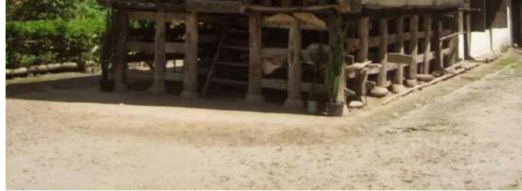
Gambar 9. Pondasi Umpak (Sumber: Adipura)
