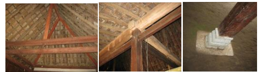
Gambar 7. Konstruksi bangunan Mantran Wetan
