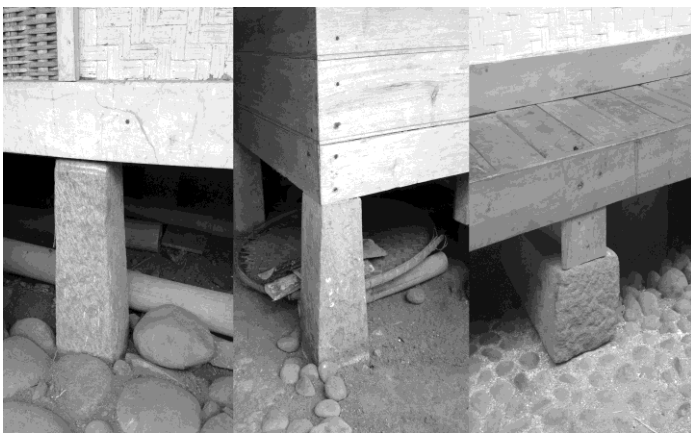
Fig.5. The Umpak Pondation of Kampung Naga
