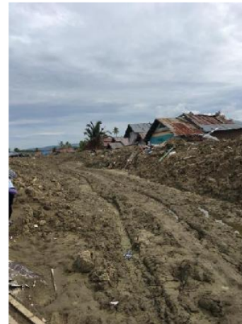
Gambar 11. Liquefaksi di wilayah Balaroa menenggelamkan perumahan sehingga hilang dari permukaan tanah
