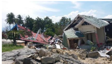
Gambar 8. Liquifaksi yang menunggangbalikkan rumah-rumah
