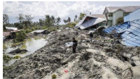
Gambar 12. Liquefaksi di wilayah Petobo yang tak kalah parahnya (Sumber: BBC News)
