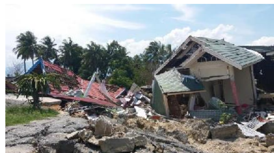
Gambar 8. Liquefaksi yang menunggangbalikkan rumah-rumah
