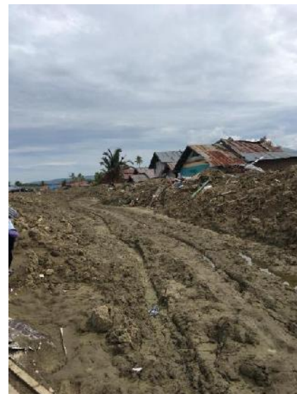
Gambar 11. Likuifaksi di wilayah Balaroa menenggelamkan perumahan sehingga hilang dari permukaan tanah
