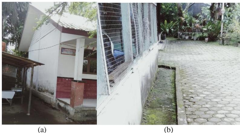
**Gambar 3.** (a) Gedung SD Negeri 064 Jalan Bunga Rampai, Medan Tuntungan, miring ke arah belakang (3b) Bekas genangan air (tembok warna hitam) akibat penurunan muka tanah di Sub-Puskesmas Kelurahan Gedung Johor, 12 September 2023
