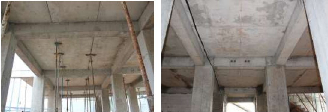
Gambar 98 : Foto balok beton
