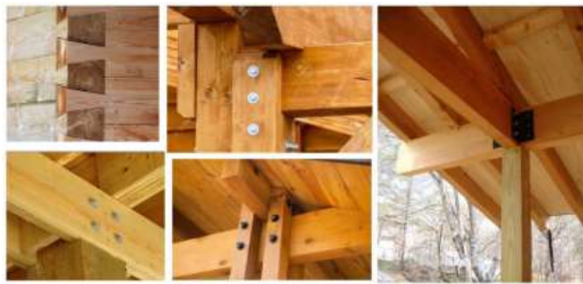
Gambar 43 : Foto hubungan kolom dan balok kayu (sumber : dokumentasi penulis)
