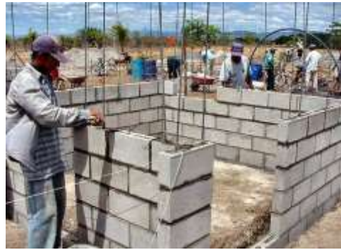
Gambar 49 : Foto dinding dengan material batako (bata beton berongga) (Sumber dokumentasi penulis)
