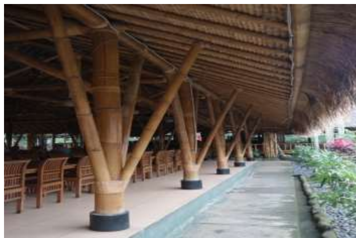
Gambar 40 : Foto bambu dipakai sebagai kolom bangunan tidak bertingkat dan bertingkat (sumber dokumentasi penulis)
