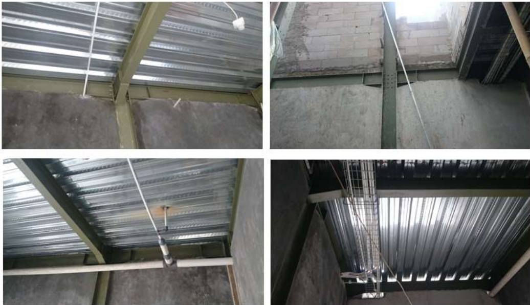
Gambar 99 : Bahan kolom dan baja IWF, lantai plat bondex (sumber dokumentasi penulis)
