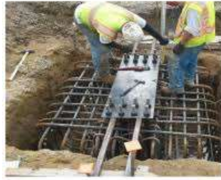
Gambar 38 : Foto hubungan antara penulangan sloof, kolom dan pondai (sumber dokumentasi penulis)
