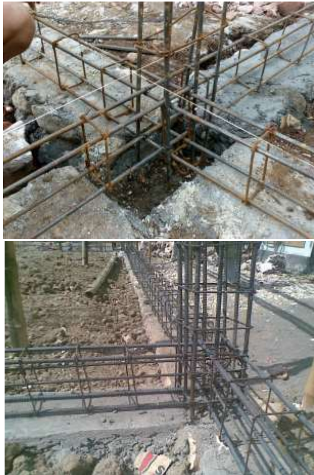
Gambar 55 : Foto pondasi batu kali, penulangan sloof (Sumber : dokumentasi penulis)
