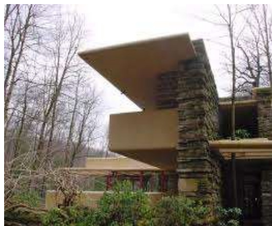
Gambar 15 : Foto sistem struktur kantilever pada bangunan, penyaluran beban merata dari atap, lantai, balok dan kolom, menerus sampai ke pondasi. (sumber dokumentasi penulis)
