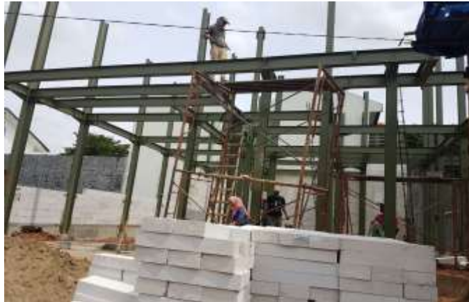
Gambar 41 : Foto hubungan kolom, balok dan plat baja (sumber dokumentasi penulis)
