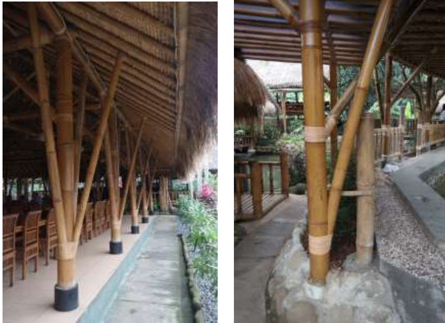
Gambar 44 : Foto hubungan kolom dan balok bambu (sumber : dokumentasi penulis)
