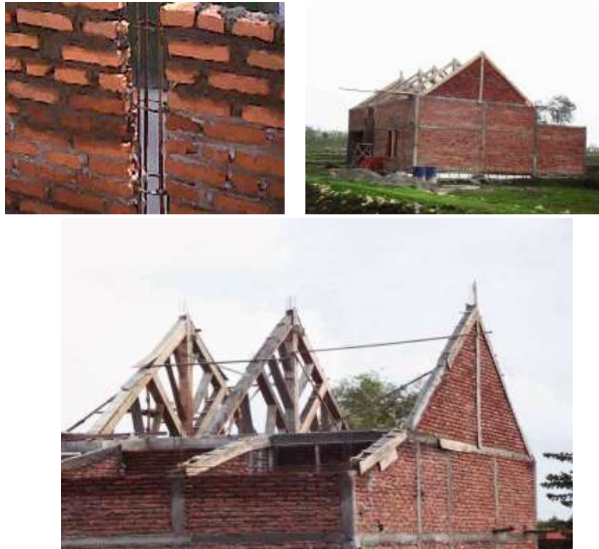
Gambar 47 : Foto pemasangan bata untuk dinding luar, struktur kuda-kuda beton bertulang, penguatan dinding (sumber : dokumentasi penulis)
