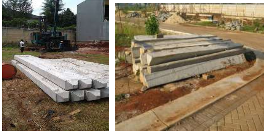
Gambar 58 : Foto pondasi tiang pancang (sumber dokumentasi penulis)
