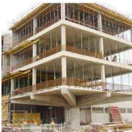
Gambar 15 : Foto sistem struktur kantilever pada bangunan, penyaluran beban merata dari atap, lantai, balok dan kolom, menerus sampai ke pondasi. (sumber dokumentasi penulis)
