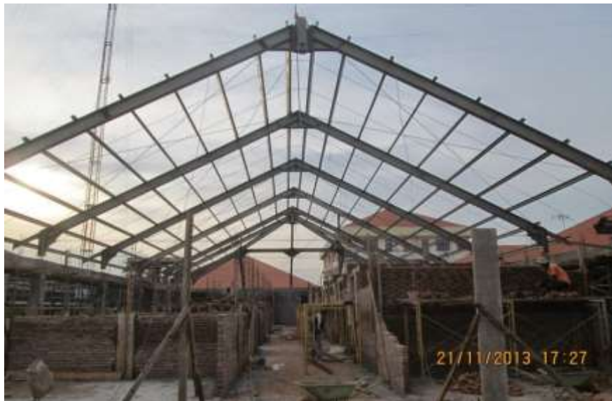
Gambar 87 : Foto kuda kuda baja IWF (sumber dokumentasi penulis)
