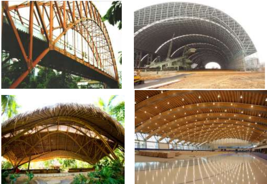
Gambar 24 : Foto struktur rangka type struktur pelengkung berbagai penggunaan, dan bahan (sumber dokumentasi penulis)
