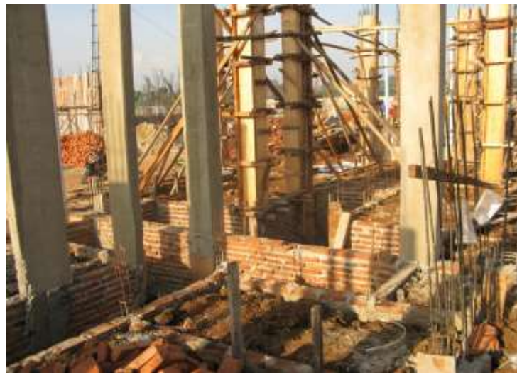
Gambar 29 : Foto Struktur bangunan bertingkat dengan bahan beton bertulang (sumber dokumentasi pribadi)
