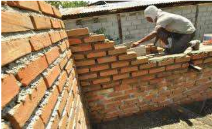
Gambar 10 : Foto pekerjaan konstruksi pemasangan dinding bata, perhatikan susunan bata yang mengikat bata satu sama lain (sumber dokumentasi penulis)
