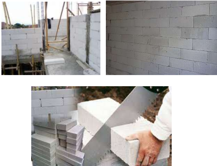
Gambar 48 : Foto pemasangan bata ringan (Sumber dokumentasi penulis)
