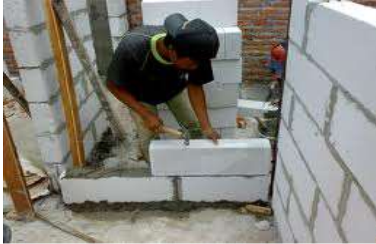
Gambar 9 : Foto pekerjaan konstruksi pemasangan dinding bata ringan, (sumber foto dokumentasi penulis)
