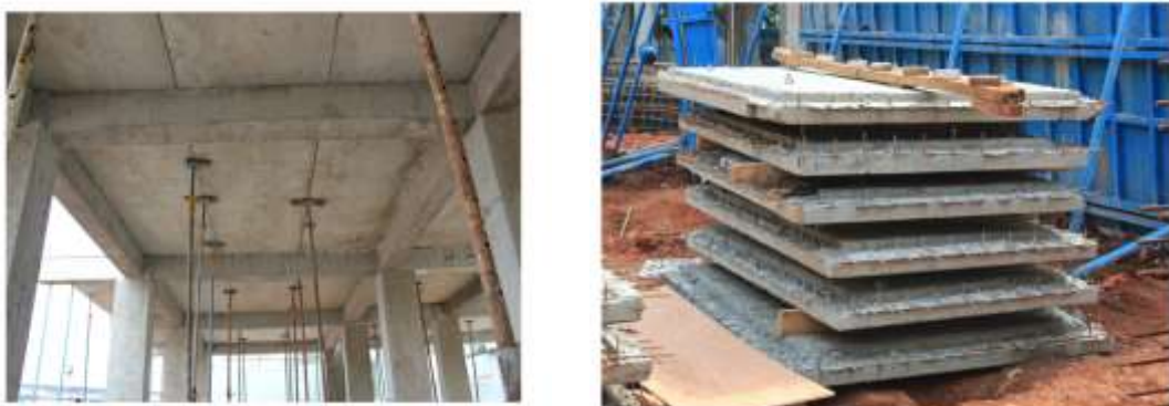
Gambar 100 : Foto balok beton bertulang, plat lantai system prefabrikasi (pre cast) (Sumber dokumentasi penulis)
