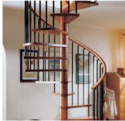
HUBUNGAN BALOK DENGAN DINDING, HUBUNGAN TIANG UTAMA BAJA DENGAN ANAK TANGGA, MELINGKAR
