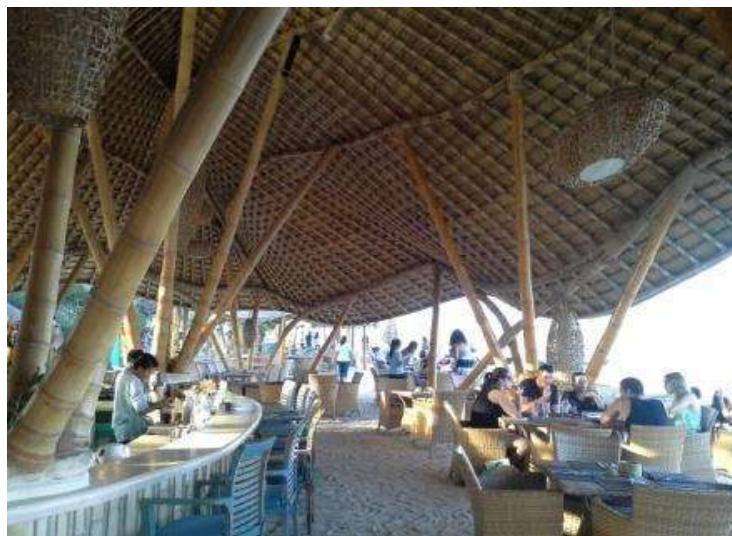
Gambar 26 : Foto bambu dipakai sebagai elemen struktur bangunan (Sumber dokumentasi penulis)
