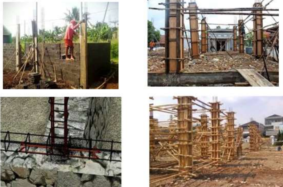
Gambar 36 : Foto contoh hubungan antara pondasi, sloof dan kolom (sumber dokumentasi penulis)
