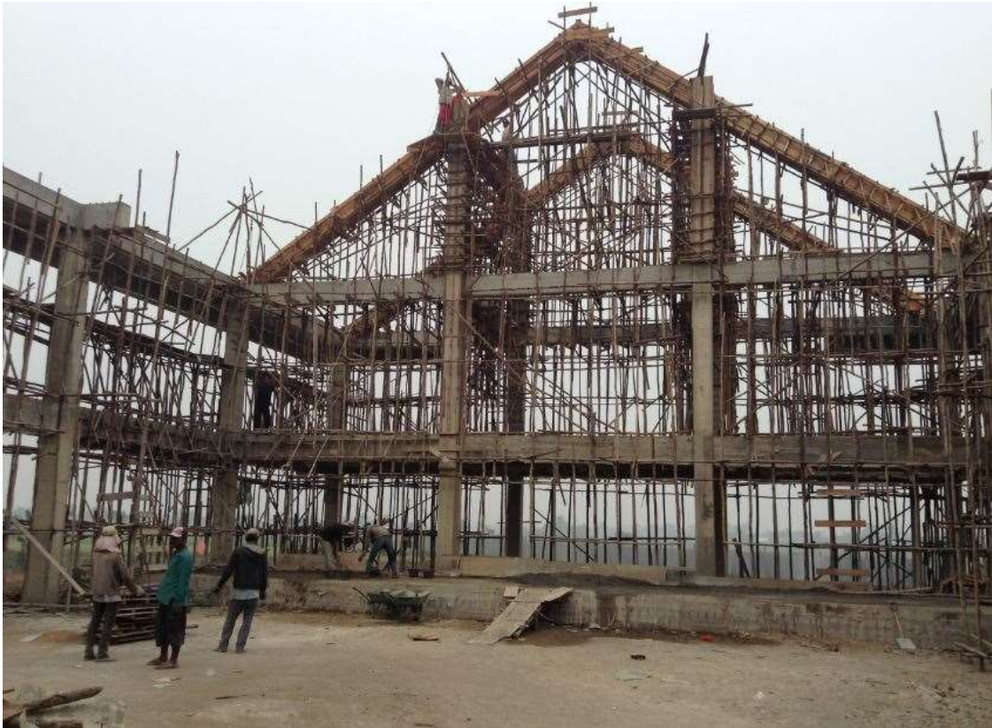
Gambar 78 : Foto kuda-kuda beton bertulang (Sumber dokumentasi penulis)
