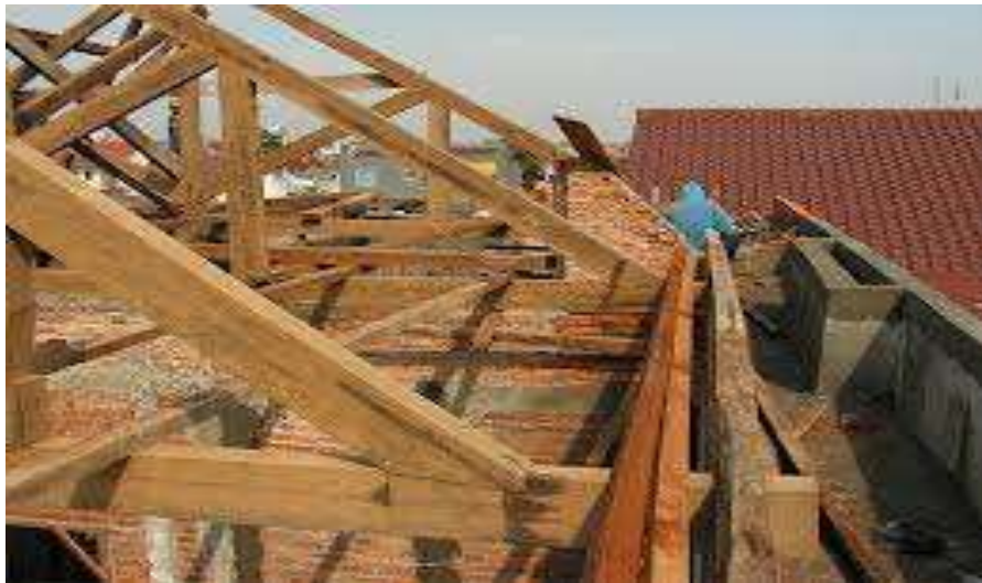
Gambar 79 : Foto kuda-kuda kayu, diatas tumpuan balok, (Sumber dokumentasi penulis)
