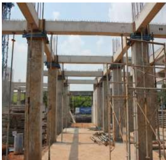
Gambar 42 : Foto hubungan kolom dan balok beton, (sumber : dokumentasi penulis)
