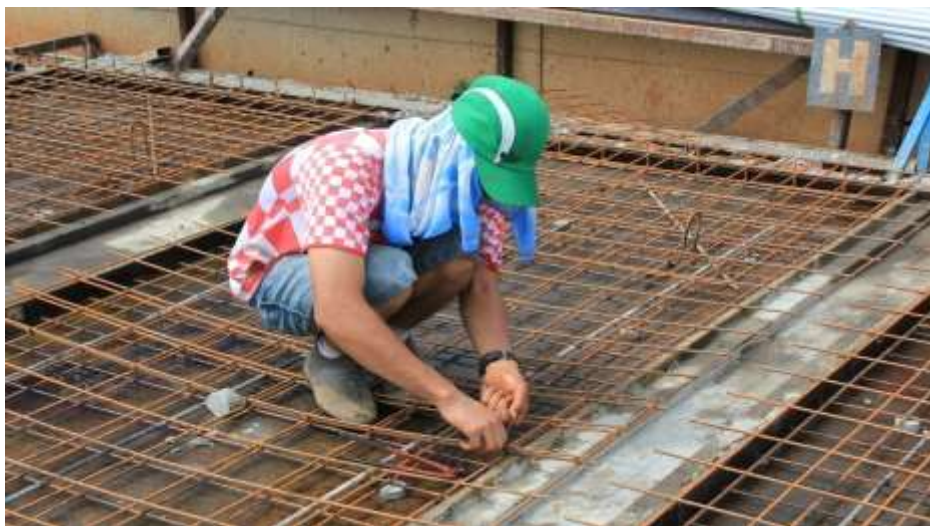
Gambar 8 : Foto pekerjaan konstruksi, berupa pekerjaan pembesian/penulangan besi baja untuk plat lantai. (sumber dokumentasi penulis)
