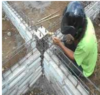
Gambar 38 : Foto hubungan antara penulangan sloof, kolom dan pondai (sumber dokumentasi penulis)
