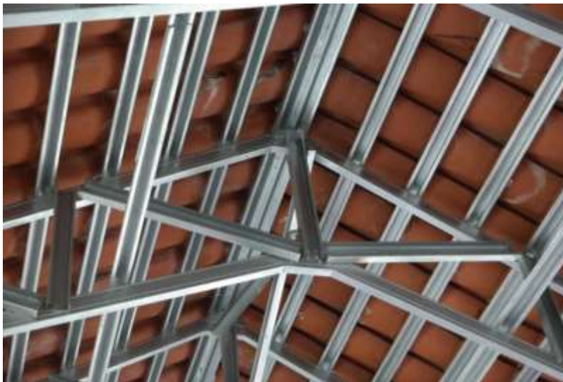
Gambar 85 : Foto kuda kuda baja ringan (sumber dokumentasi penulis)
