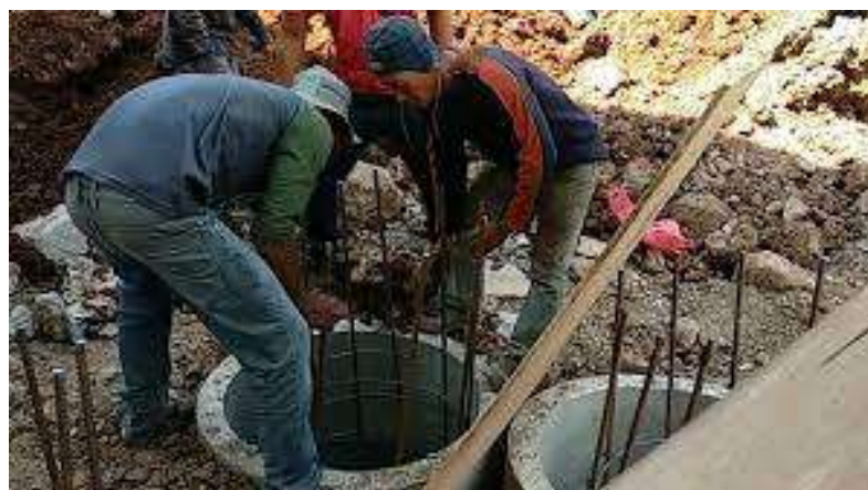
Gambar 57 : sketsa dan foto pondasi sumuran (sumber dokumentasi penulis)
