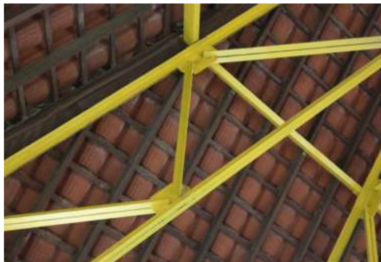
Gambar 86 : Skets Detil sambungan kuda kuda baja siku (Sumber skets penulis)
