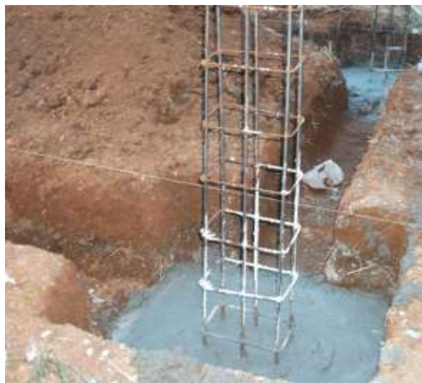
Gambar 56: Foto pondasi setempat beton bertulang (sumber : dokumentasi penulis)
