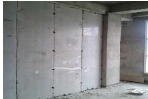
Gambar 50: Foto dinding beton precast (prefabrikasi). (Sumber dokumentasi penulis)
