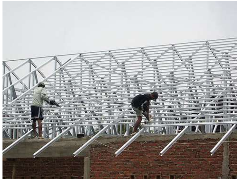
Gambar 5 : struktur atap baja ringan (sumber : dokumentasi penulis)
