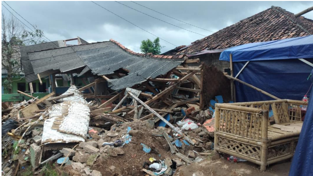
Gambar 2.11. Bagian rumah yang rusak karena banyak menggunakan bahan kayu
