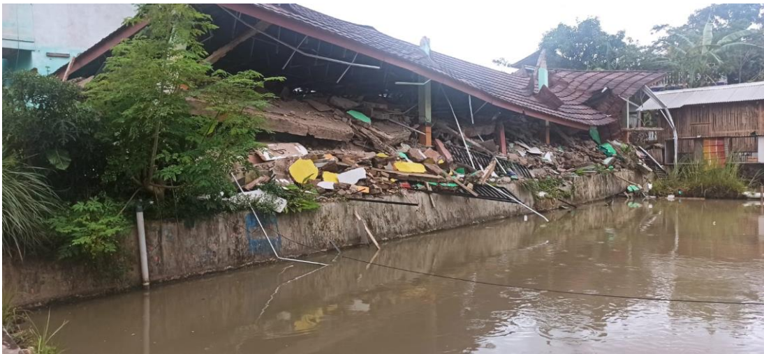
Gambar 2.8. Pondok pesantren yang lantainya rubuh terpisah dengan balok dan kolom
