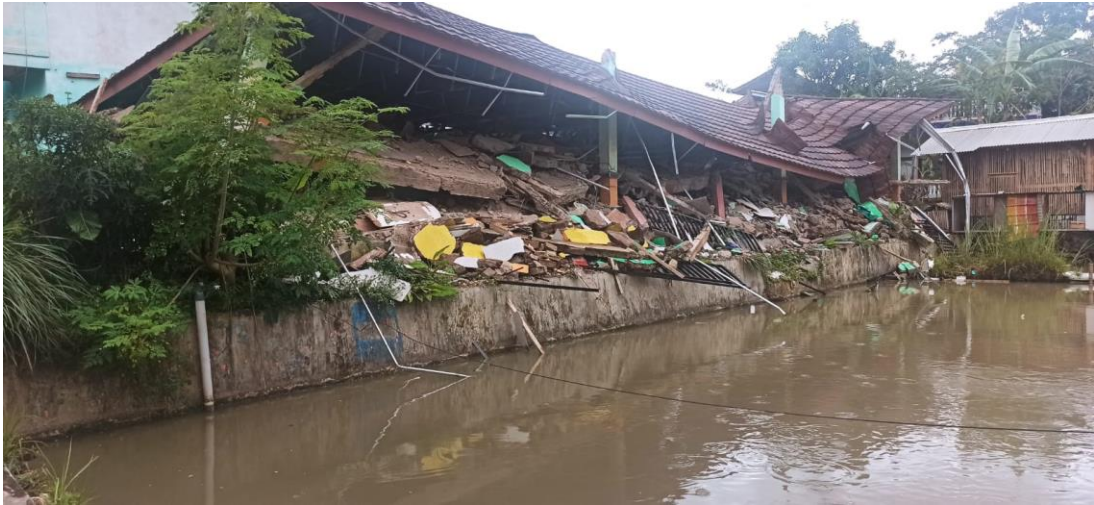
Gambar 49.8. Pondok pesantren yang lantainya rubuh terpisah dengan balok dan kolom
