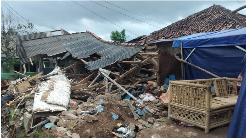
Gambar 49.12. Bagian rumah yang rusak karena banyak menggunakan bahan kayu
